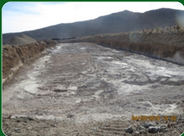
پس از اجرای پروژه
