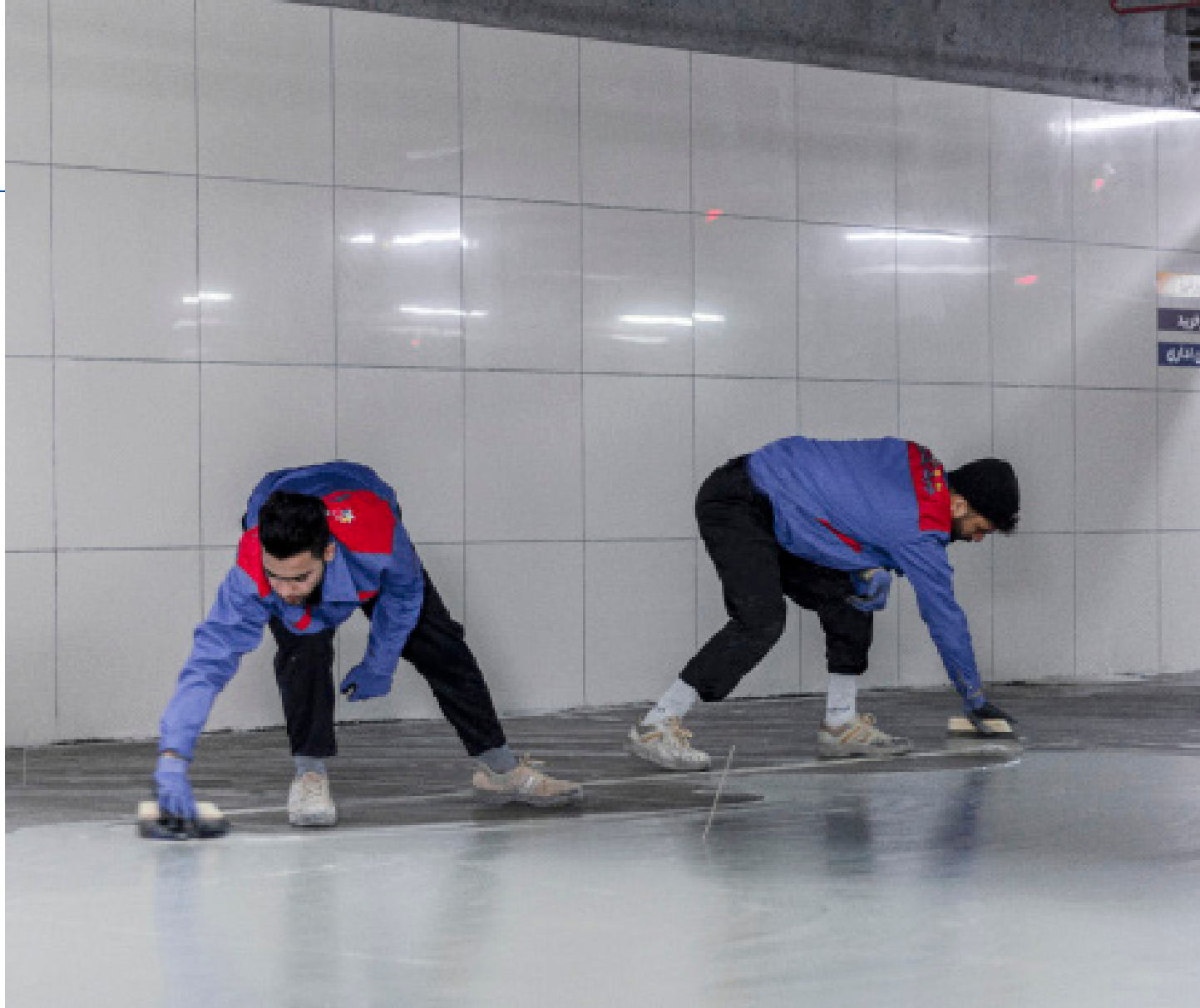
♦ پروژه مجتمع پاز مشهد
