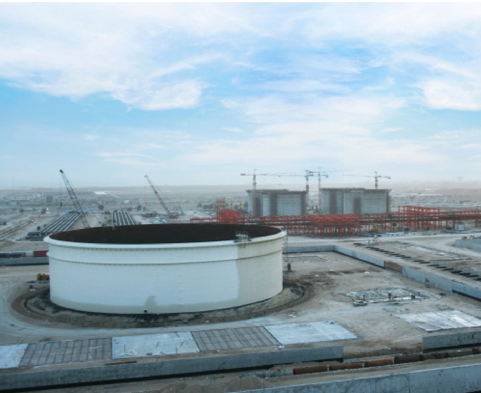
♦ پروژه مخازن فاز ۱۵ و ۱۶ عسلویه
