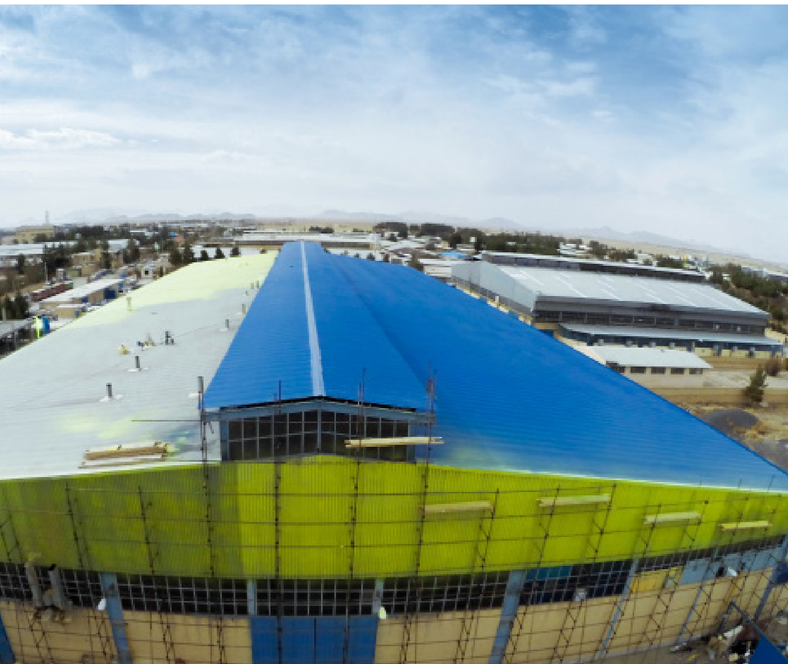
◆ پروژه کارخانجات اسنوا
